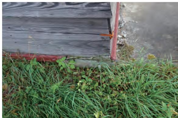
55 水切材（金属板）脱落と芯材割れ
