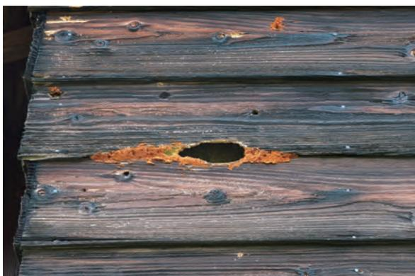
27 空隙材に穴 w110 × h45
