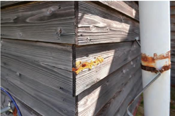
47 板割れ隙に充填材、さらに穴あき
