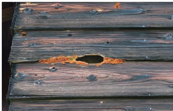
図 2-29 空隙材に穴 w110 × h45
