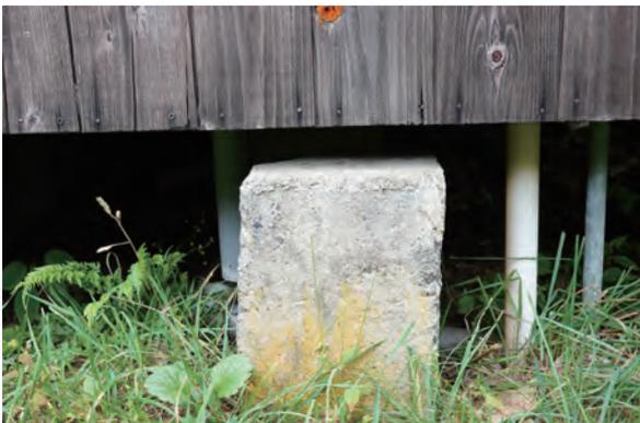
68 基礎沈下による浮き
