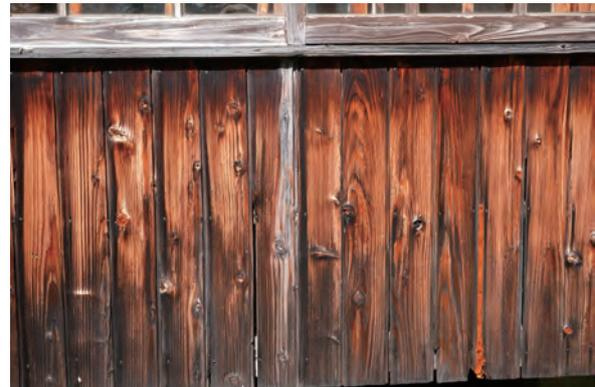
20 風食による空隙と充填材
