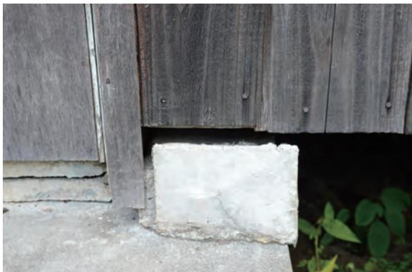
67 基礎沈下による浮き
