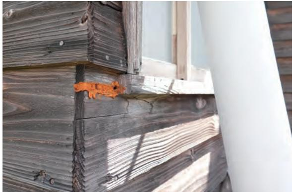
46 空隙に充填材、さらに穴あき
