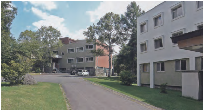
図 1-17 実験研究棟 A 棟（正面）と宿泊棟（右）（昭和 44 年築）
