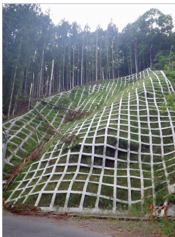
↑コンクリートで固められ、外来牧草が生やされた斜面
